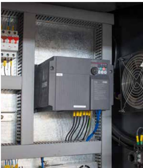
El inverter para el ajuste continuo de la velocidad de la hoja permite ajustar la velocidad de rotación de la hoja según el tipo de material.
